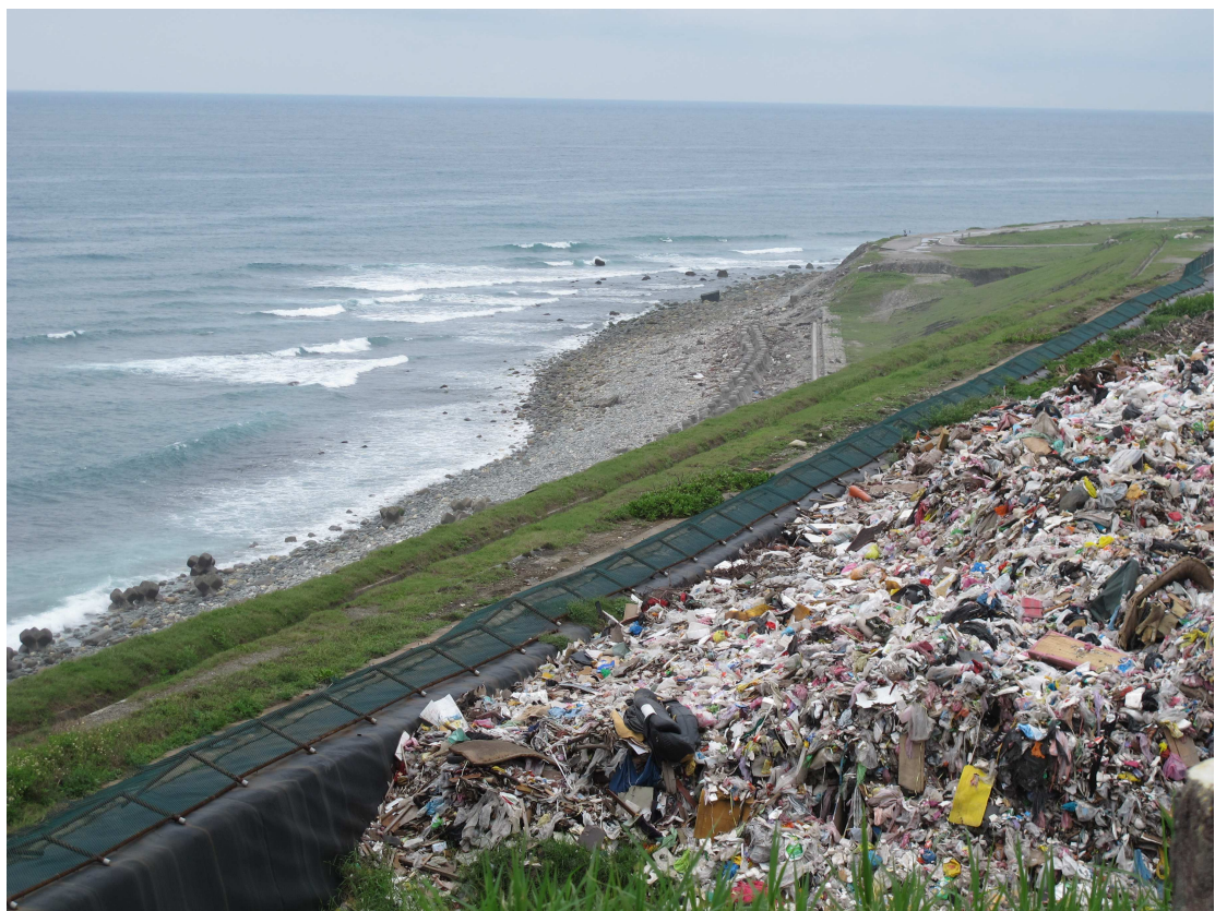
花蓮市垃圾掩埋場，近年綠美化復育改為環保公園，但隨著氣候變遷、邊坡逐漸被海浪掏空，漲潮時浪可至七公尺高，陡坡填補的土牆，有部分已被侵蝕刷落，黑潮與許多環保組織擔心將來浪會將垃圾捲回海水中，造成海洋汙染。
